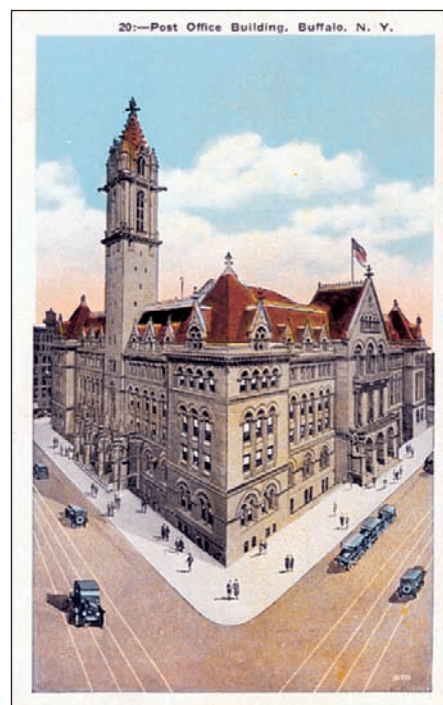
Bild 2: Postamt in Buffalo (Bundesstaat New York). Das vierstöckige Gebäude wurde gegen Ende des 19. Jhd. erbaut und enthielt einen sehr großen Betriebsaal mit einer Grundfläche von 2200m 2 hatte. Dieser war auf drei Seiten von Schaltervorräumen in einer Gesamtlänge von 115 m umgeben.
