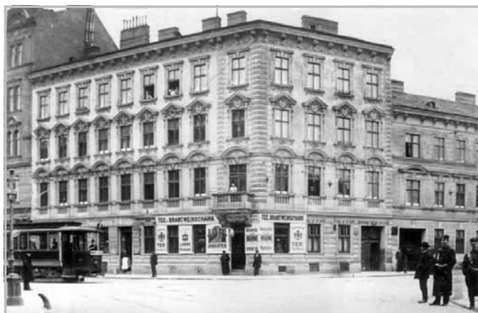
Gellertplatz (noch im Linksverkehr)
