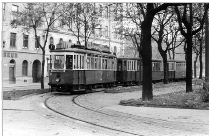
Bei der Endstelle Burggasse-Stadthalle
