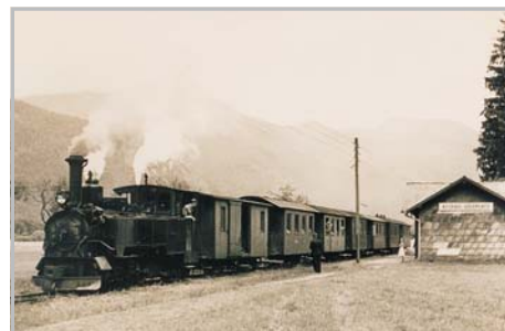
In der Haltestelle Aschau-Golfplatz steht ein Personenzug mit der Lok Nr.10 in Richtung Salzburg. Die nächste Station war die Haltestelle Wacht, die nur 1 km entfernt lag. Die Ischler Bahn benötigte für diesen kurzen Streckenabschnitt, trotz langsamer Fahrgeschwindigkeit, nur drei Minuten!
