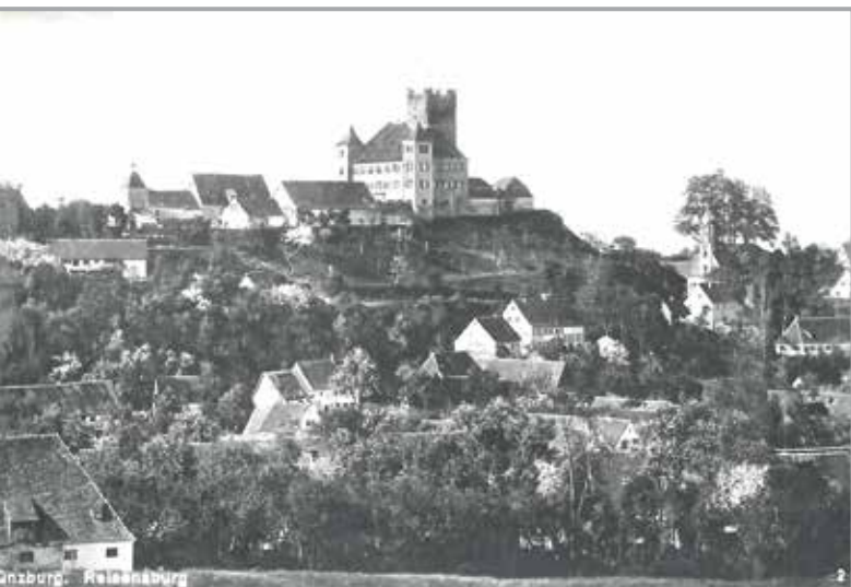
Im 16. Jb. wurde die Reisenburg zu einem Schloss umgebaut, allerdings 1632 von schwedischen Landsknechten niedergebrannt und musste neu errichtet werden.
