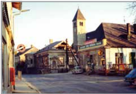
Der Abriss des Ortszentrums begann 1975 mit der Demolierung des „Bogner-Haus“ Komplexes (li).
